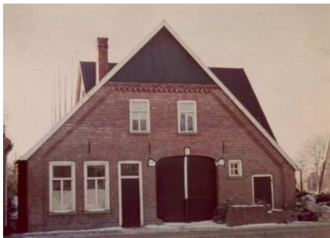
VIII Altes Wohnhaus Johann Toenhake (erbaut 1922) Dahinter sieht man bereits das Dach des Neubaus.
